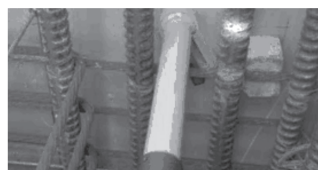
スパーサー手直し時のスラブ持ち上げ作業に
