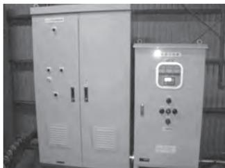
商用電源が停電した場合に、これを検知して自動的にエンジン発電機を起動し、商用電源との電源切替をおこない、負荷に給電をおこなう装置です。
