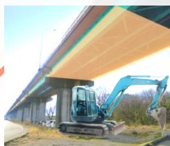
橋梁下での作業
