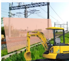
線路際での作業
