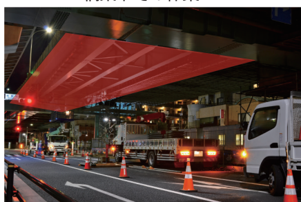
橋梁下での作業
